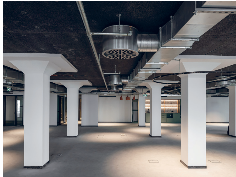
GR-RR Κτίριο γραφείων Office building
